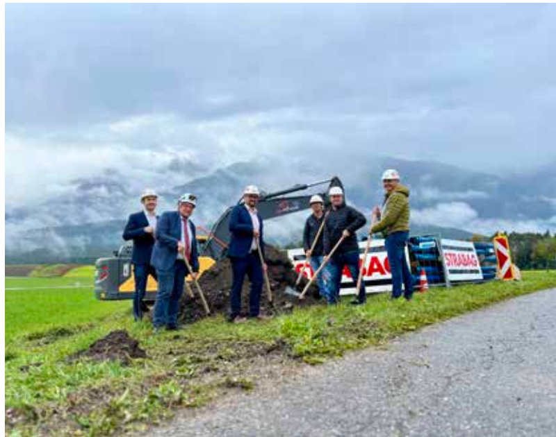
Spatenstich für die Bauarbeiten
